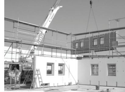
Slika 1c: Panelni okvirni sistem
